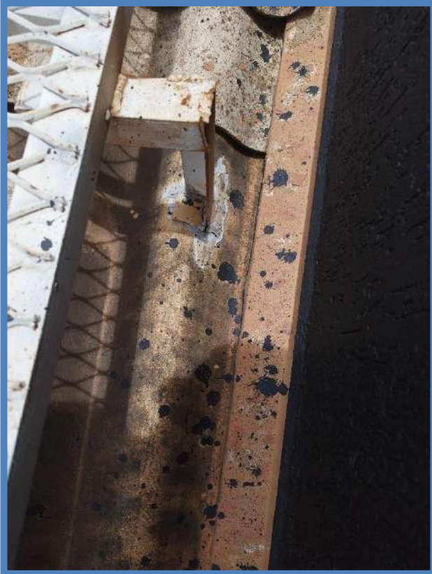
Figura 199: BLOCO B – COBERTURA
