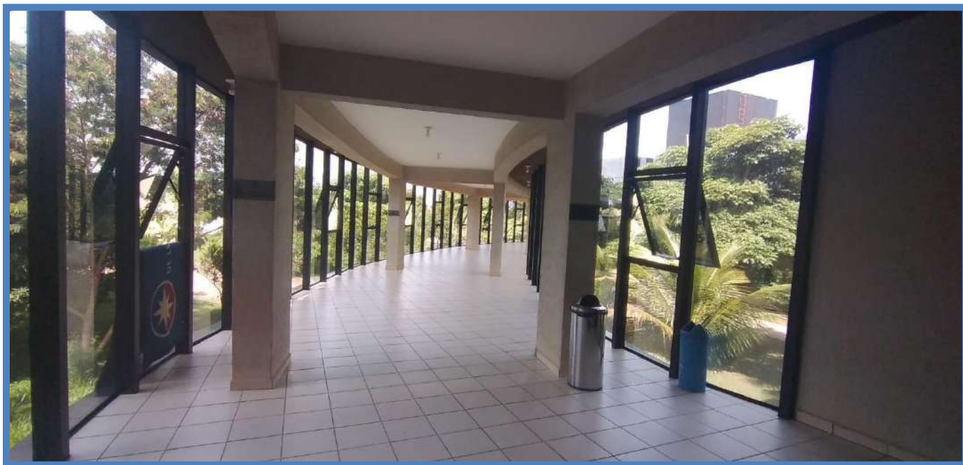
Figura 153: RAMPA DE ACESSO ENTRE OS BLOCOS A E B
