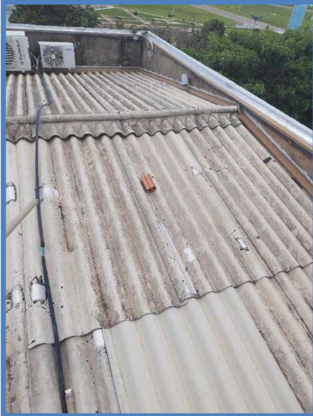
Figura 191: BLOCO B – COBERTURA
