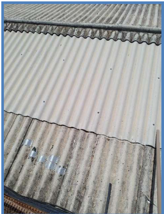
Figura 140: BLOCO A – 2º PAVIMENTO – COBERTURA
