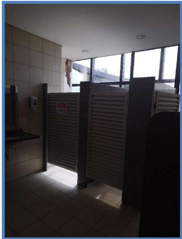
Figura 54: BLOCO A – 1º PAVIMENTO – SANITÁRIO MASCULINO
