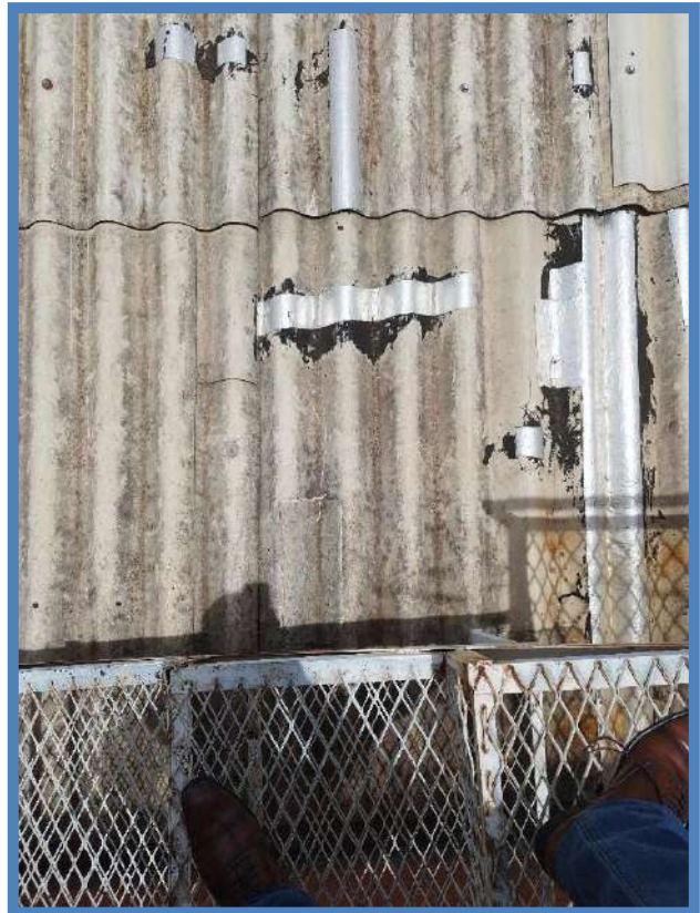
Figura 204: BLOCO B – COBERTURA
