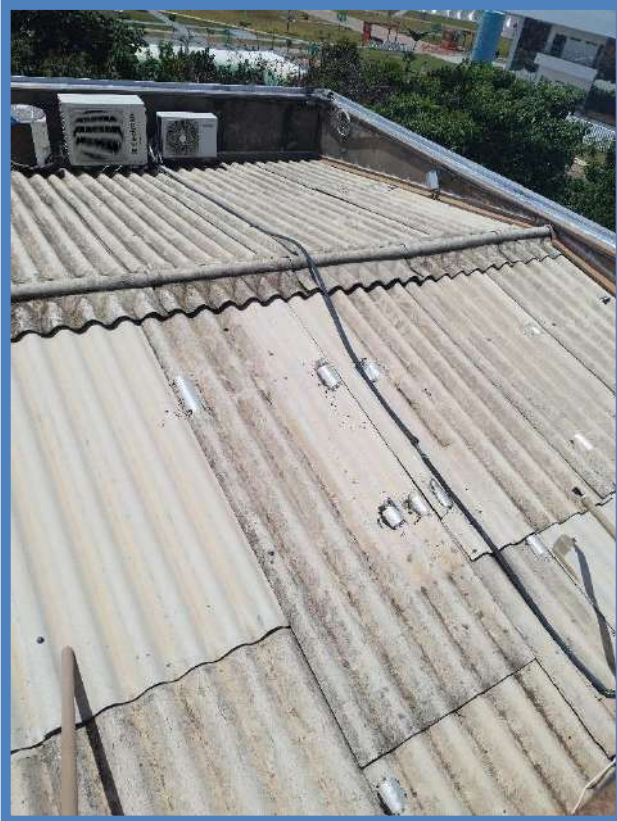
Figura 137: : BLOCO A – 2º PAVIMENTO – COBERTURA
