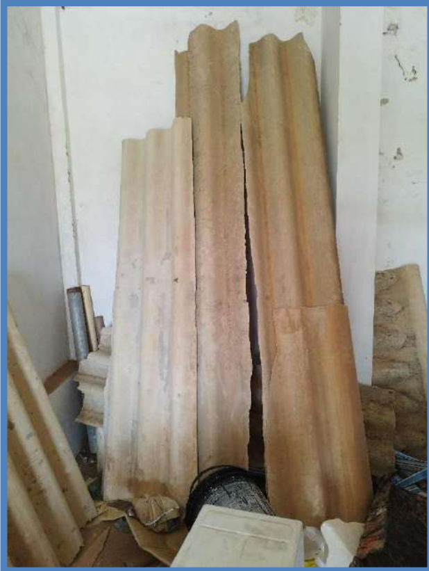
Figura 223: BLOCO B – ACESSO A COBERTURA
