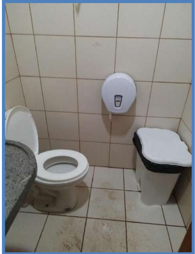
Figura 14: BLOCO A – TÉRREO – BANHEIRO FEMININO
