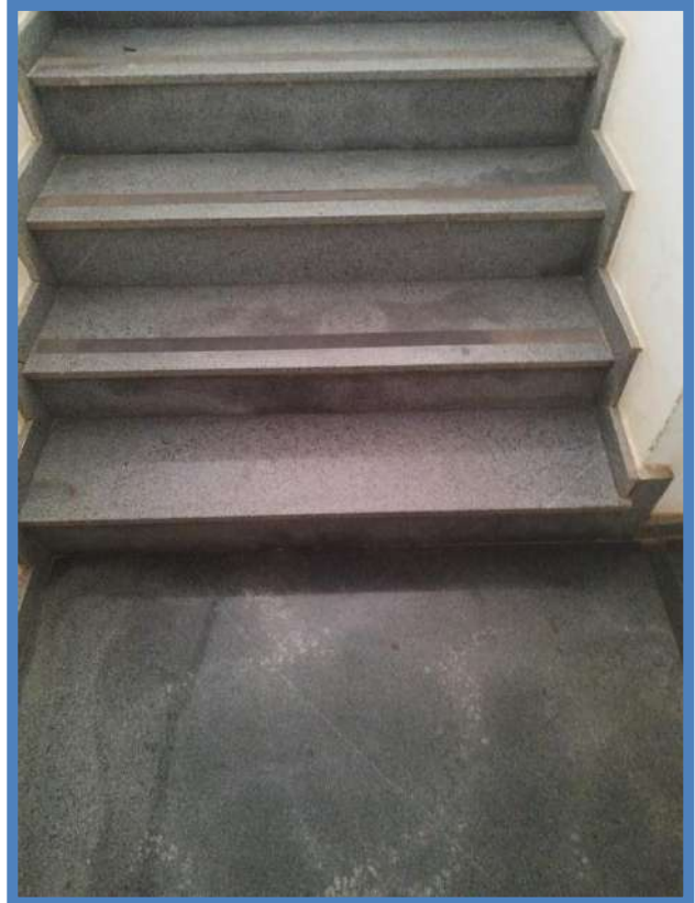
Figura 38: BLOCO A – TÉRREO – ESCADA
