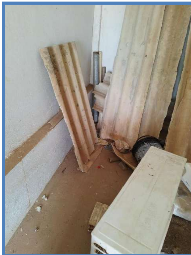
Figura 225: : BLOCO B – ACESSO A COBERTURA
