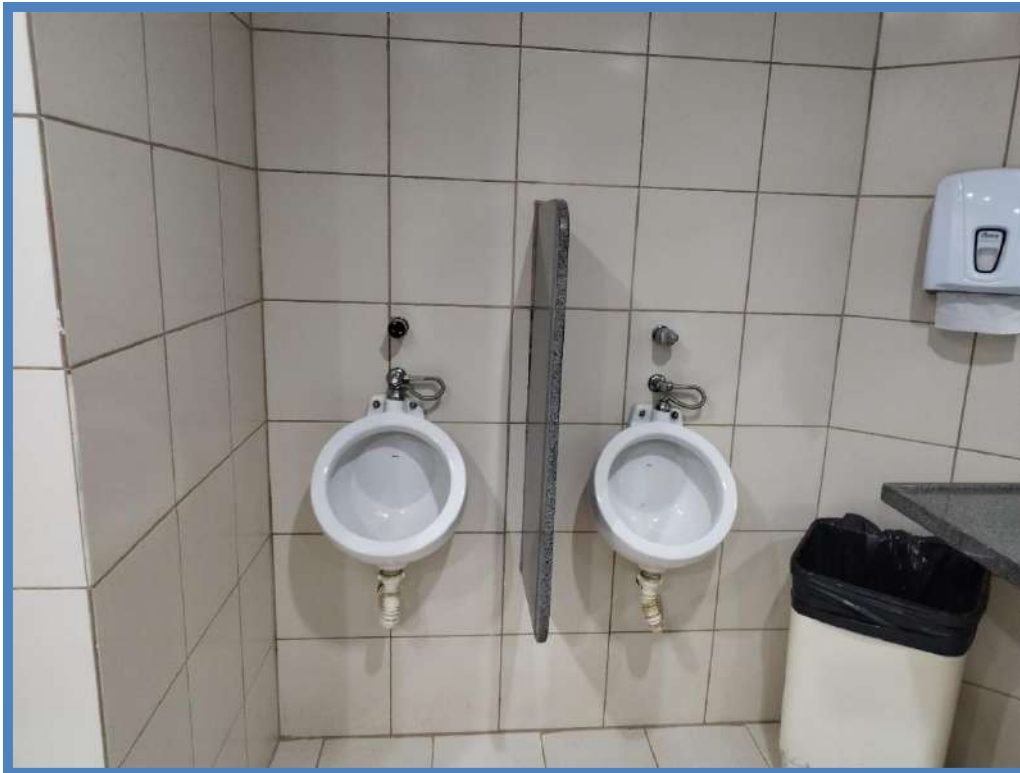
Figura 234: BLOCO B - 1º PAVIMENTO - BANHEIRO
