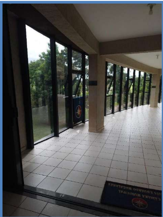
Figura 43: BLOCO A – 1º PAVIMENTO – RAMPA PARA O TÉRRO
