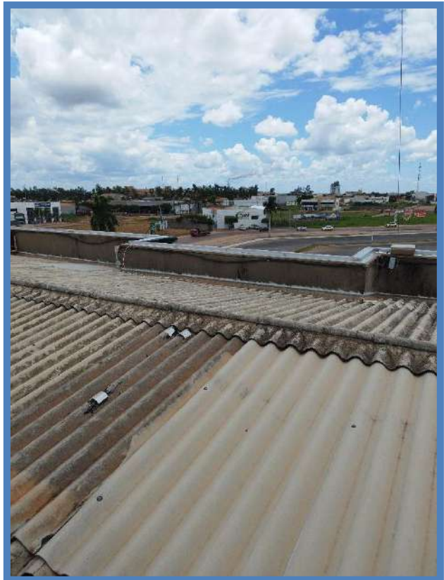
Figura 180: BLOCO B – COBERTURA
