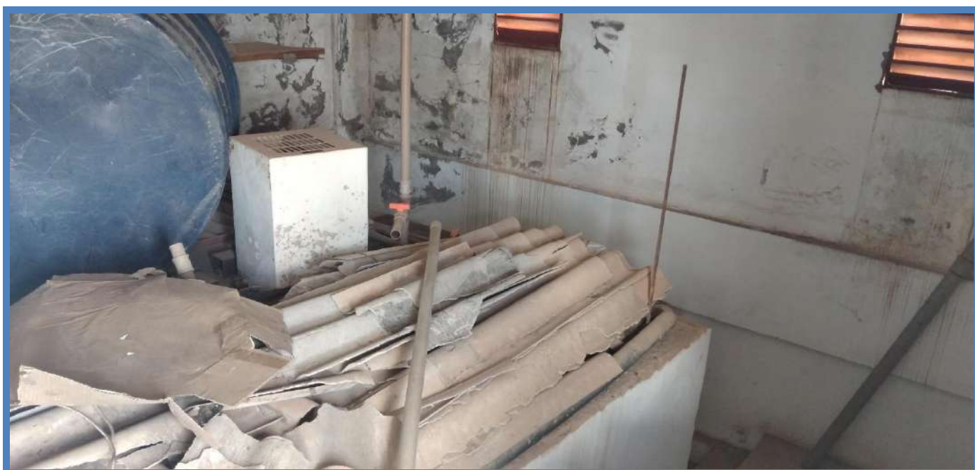
Figura 160: BLOCO A – HALL DE ACESSO A COBERTURA (EMBAIXO DO RESERVATÓRIO DE ÁGUA)
