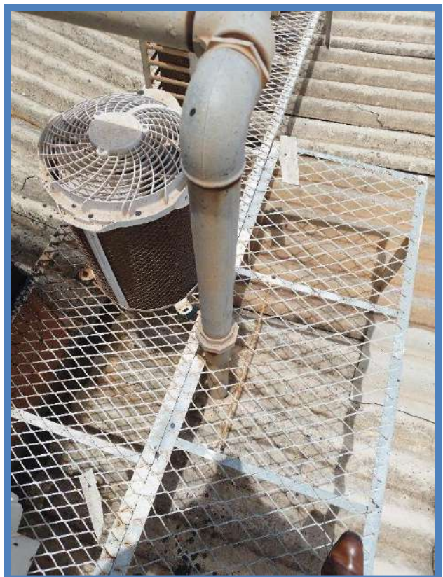
Figura 210: BLOCO B – COBERTURA
