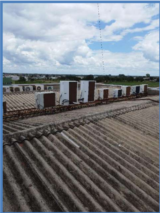
Figura 183: BLOCO B – COBERTURA
