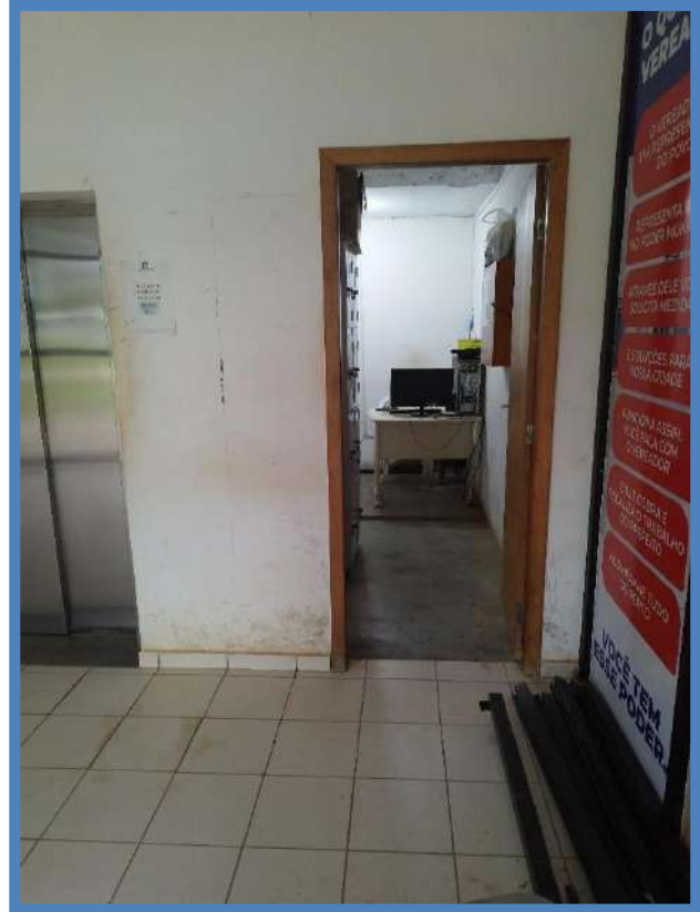
Figura 30: BLOCO A – TÉRREO – HALL DO ELEVADOR
