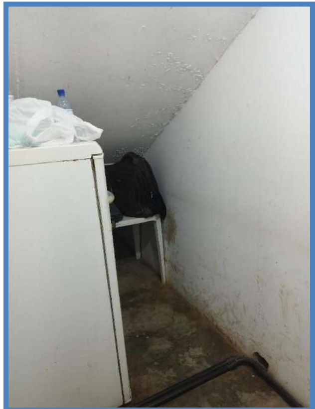
Figura 32: BLOCO A – TÉRREO – DEPÓSITO
