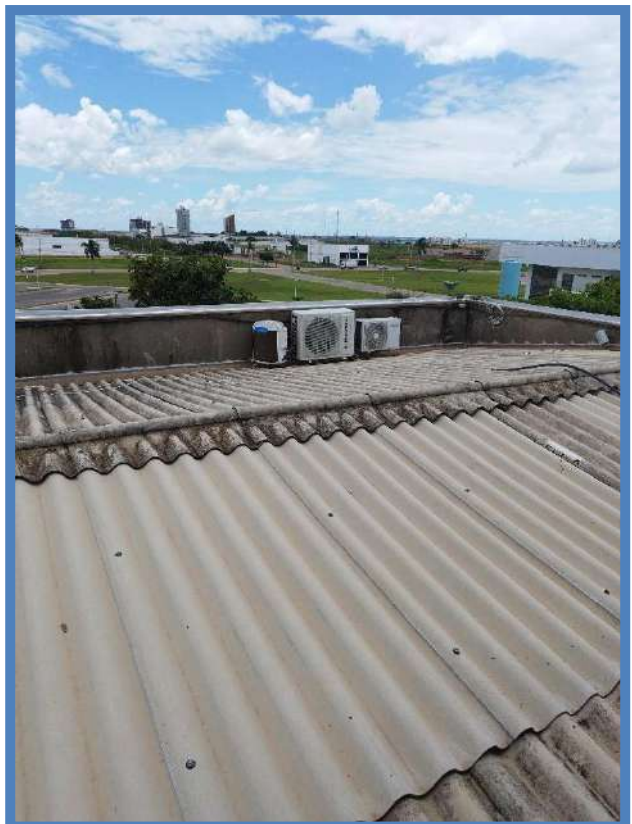
Figura 178: BLOCO B – COBERTURA
