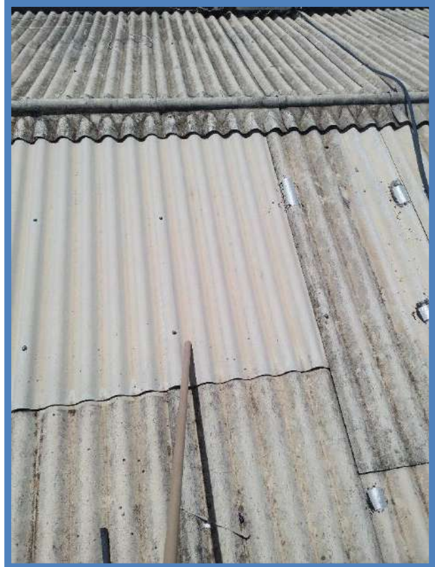
Figura 138: BLOCO A – 2º PAVIMENTO – COBERTURA
