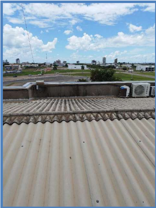
Figura 179: BLOCO B – COBERTURA
