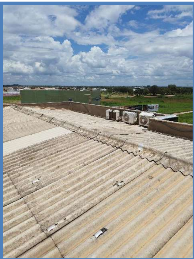
Figura 217: BLOCO B – COBERTURA
