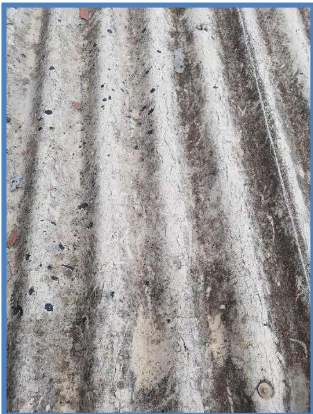
Figura 197: BLOCO B – COBERTURA
