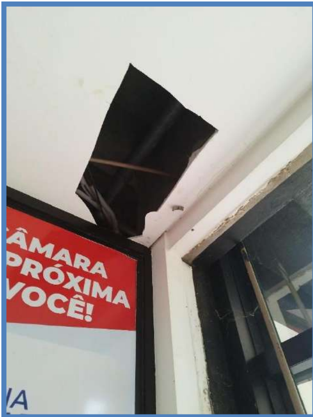
Figura 33: BLOCO A – TÉRREO – HALL DO ELEVADOR
