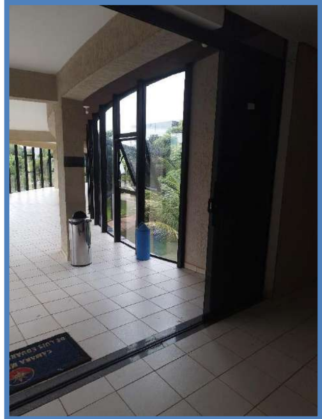
Figura 42: BLOCO A – 1º PAVIMENTO – RAMPA PARA O TÉRRO
