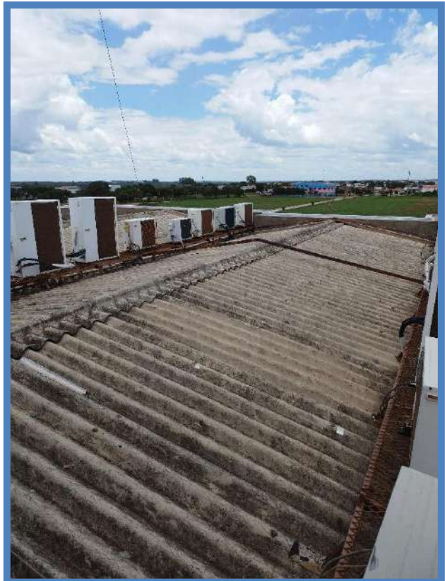
Figura 184: BLOCO B – COBERTURA
