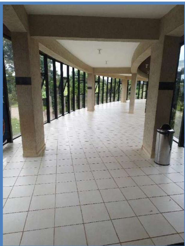
Figura 99: RAMPA DE ACESSO ENTRE OS BLOCOS A E B
