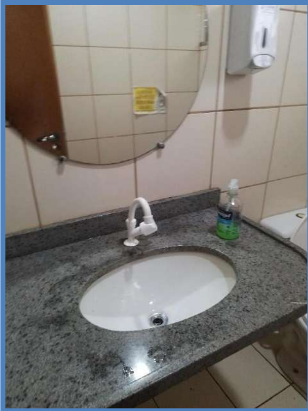
Figura 13: BLOCO A – TÉRREO – BANHEIRO FEMININO
