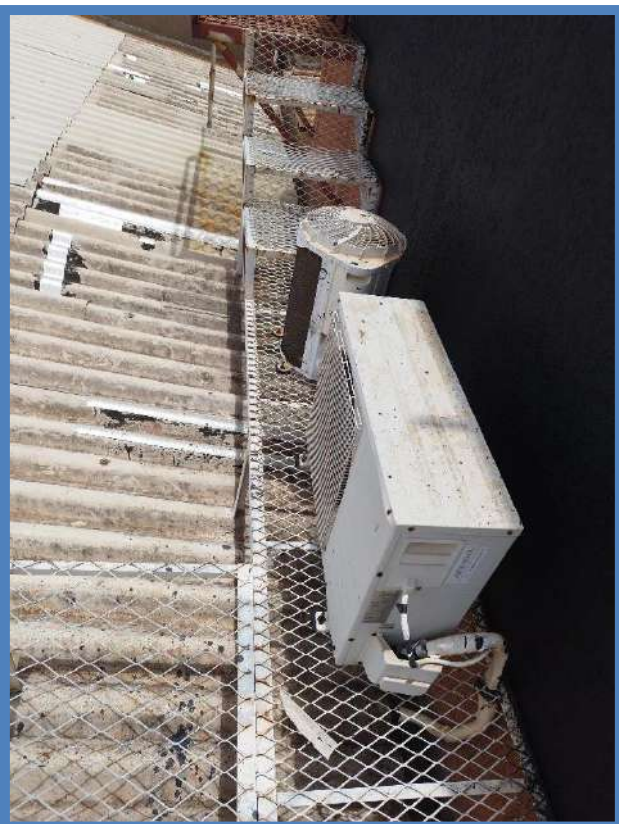
Figura 221: BLOCO B – COBERTURA
