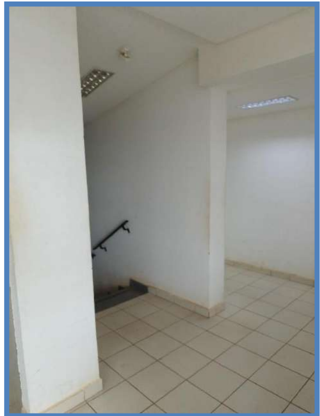
Figura 118: BLOCO A – 2º PAVIMENTO – RECEPÇÃO
