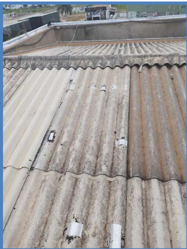
Figura 193: BLOCO B – COBERTURA
