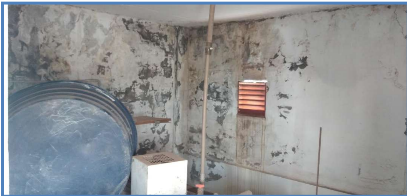
Figura 159: BLOCO A – HALL DE ACESSO A COBERTURA (EMBAIXO DO RESERVATÓRIO DE ÁGUA)
