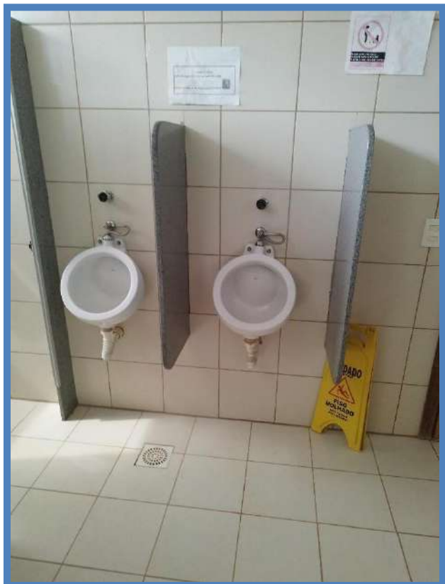
Figura 56: BLOCO A – 1º PAVIMENTO – SANITÁRIO MASCULINO
