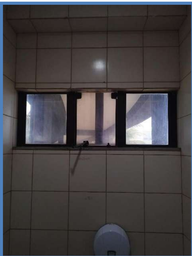
Figura 15: BLOCO A – TÉRREO – BANHEIRO FEMININO
