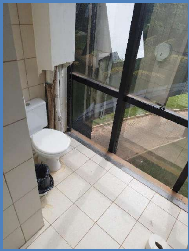
Figura 61: BLOCO A – 1º PAVIMENTO – SANITÁRIO MASCULINO
