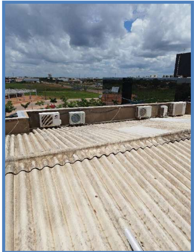
Figura 216: BLOCO B – COBERTURA
