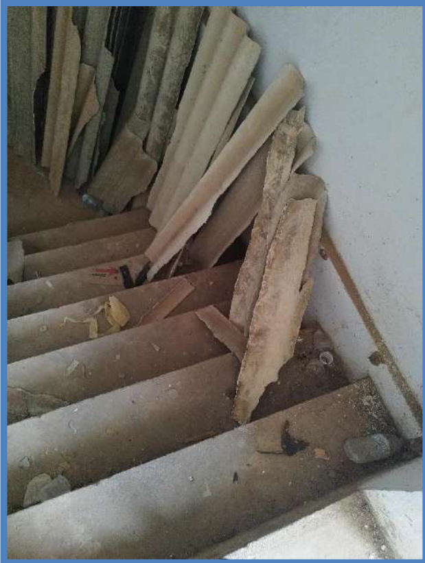
Figura 195: BLOCO B – ACESSO A COBERTURA
