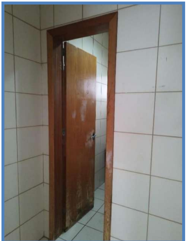
Figura 4: BLOCO A – TÉRREO – ENTRADA BANHEIRO
