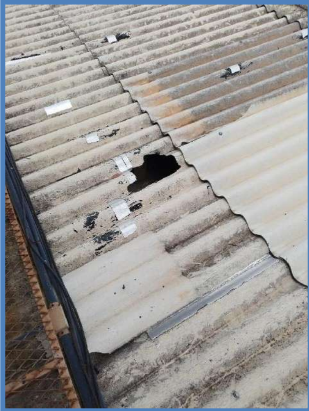
Figura 175: BLOCO B – COBERTURA
