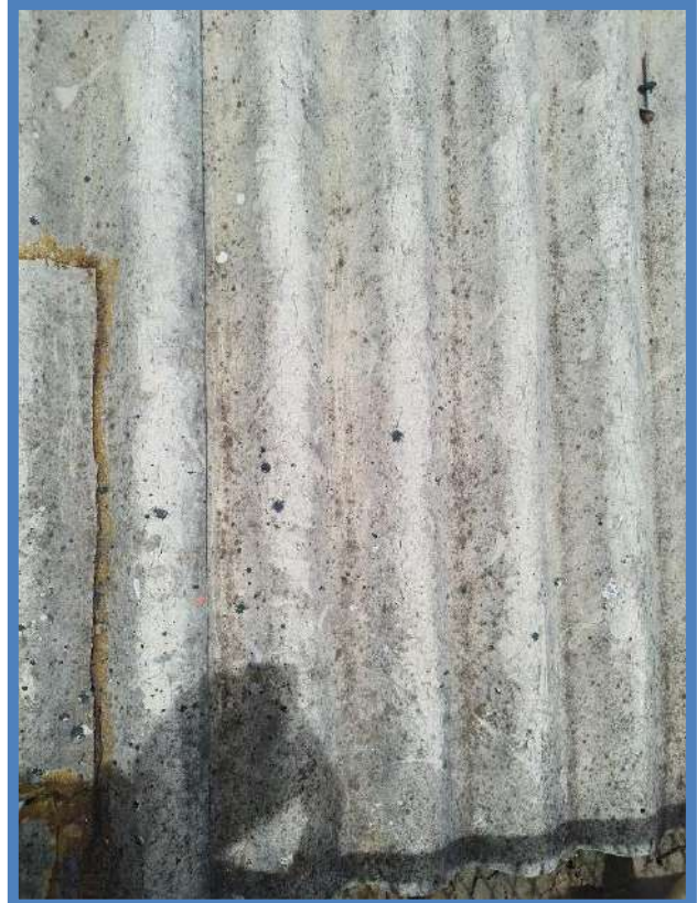
Figura 212: BLOCO B – COBERTURA
