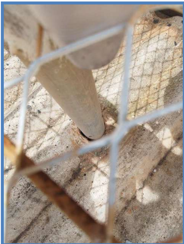
Figura 209: BLOCO B – COBERTURA
