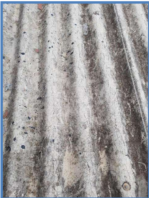
Figura 185: BLOCO B – COBERTURA
