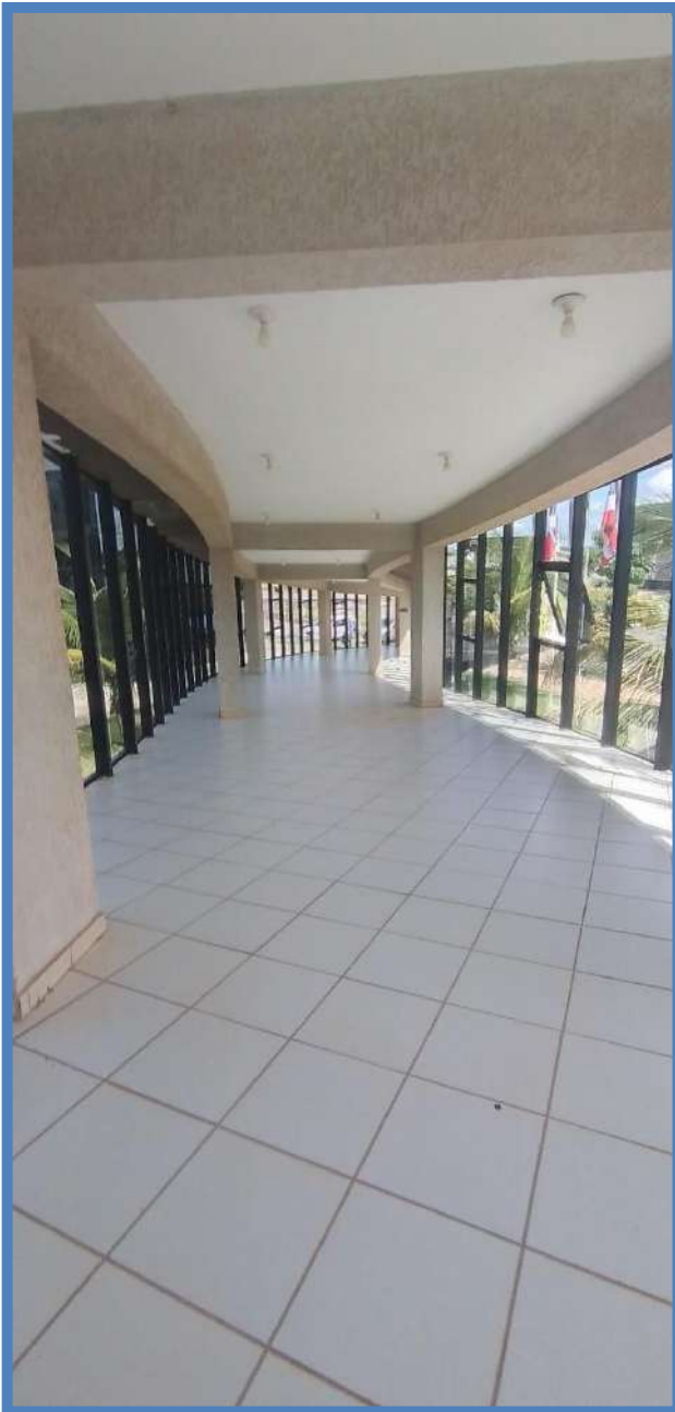
Figura 149: RAMPA DE ACESSO ENTRE OS BLOCOS A E B
