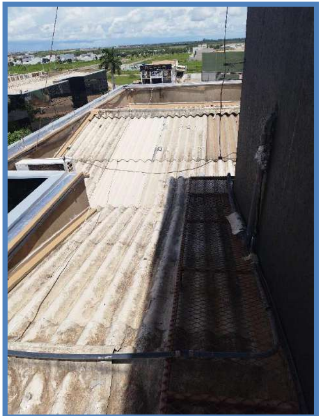
Figura 144: BLOCO A – 2º PAVIMENTO – COBERTURA
