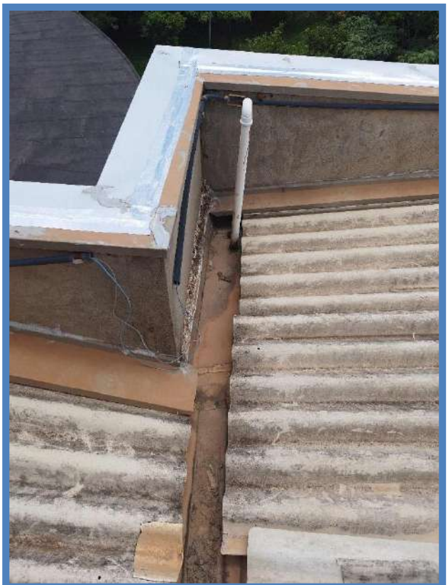
Figura 202: BLOCO B – COBERTURA
