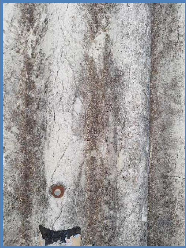
Figura 187: BLOCO B – COBERTURA
