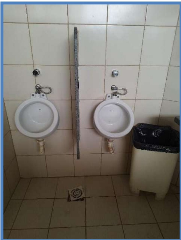
Figura 55: BLOCO A – 1º PAVIMENTO – SANITÁRIO MASCULINO
