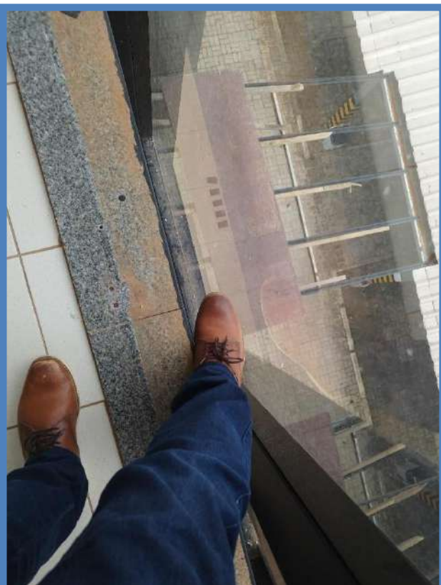
Figura 135: BLOCO A – 2º PAVIMENTO – SANITÁRIO FEM.
