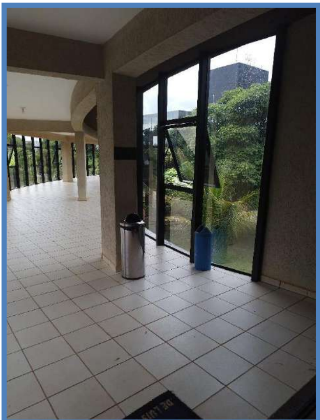
Figura 100: RAMPA DE ACESSO ENTRE OS BLOCOS A E B
