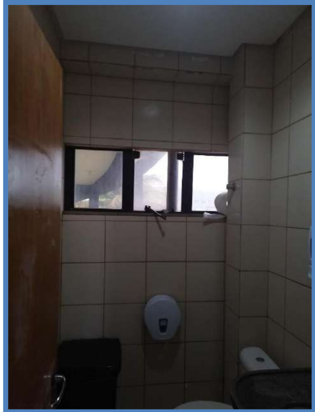
Figura 6: BLOCO A – TÉRREO – BANHEIRO
