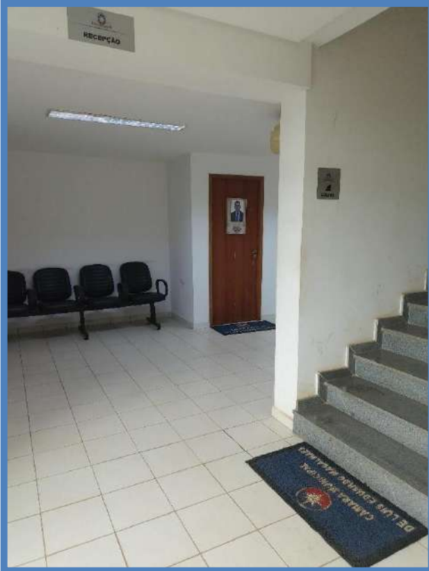
Figura 121: BLOCO A – 2º PAVIMENTO – RECEPÇÃO
