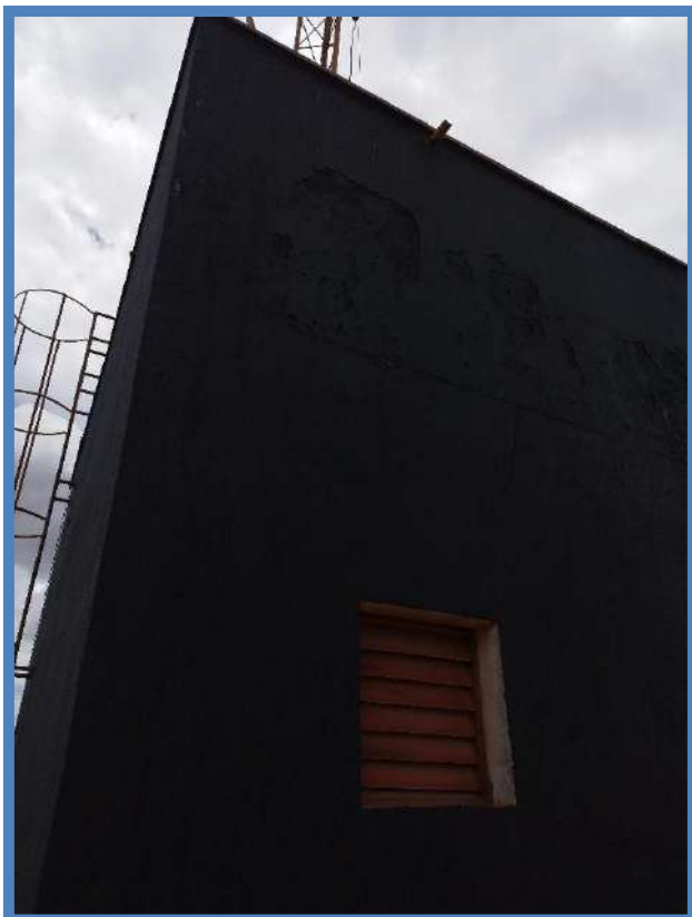
Figura 189: BLOCO B – RESERVATÓRIO DE ÁGUA
