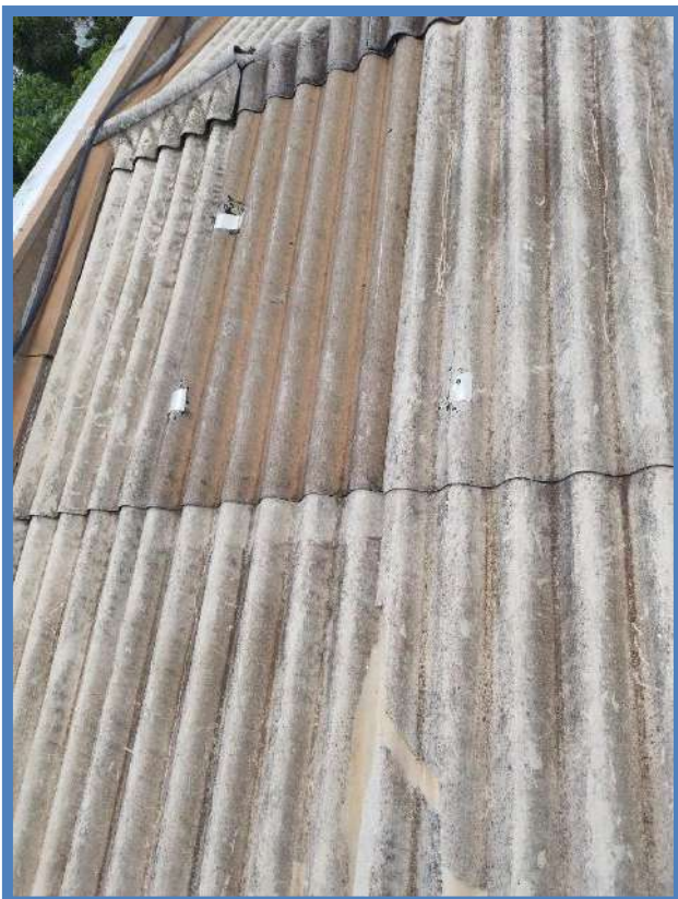
Figura 201: BLOCO B – COBERTURA
