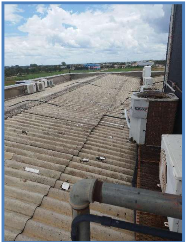
Figura 194: BLOCO B – COBERTURA
