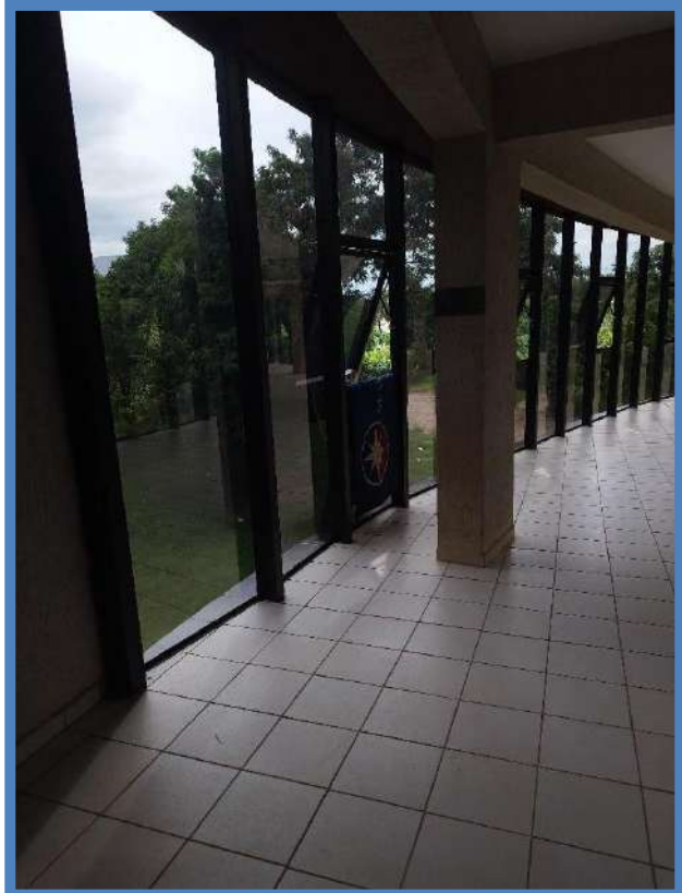
Figura 98: BLOCO A – 1º PAVIMENTO – COPA
