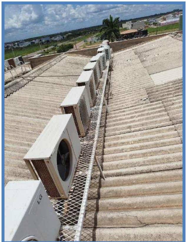
Figura 218: BLOCO B – COBERTURA
