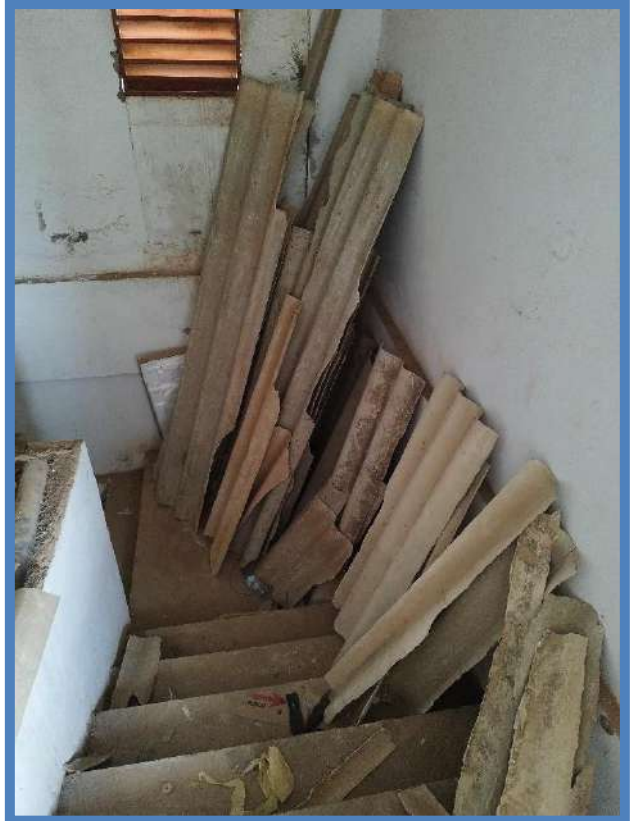
Figura 196: BLOCO B – ACESSO A COBERTURA
