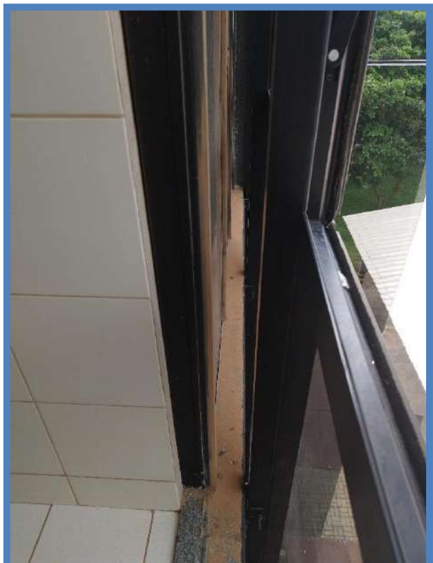
Figura 136: BLOCO A – 2º PAVIMENTO – SANITÁRIO FEM.
