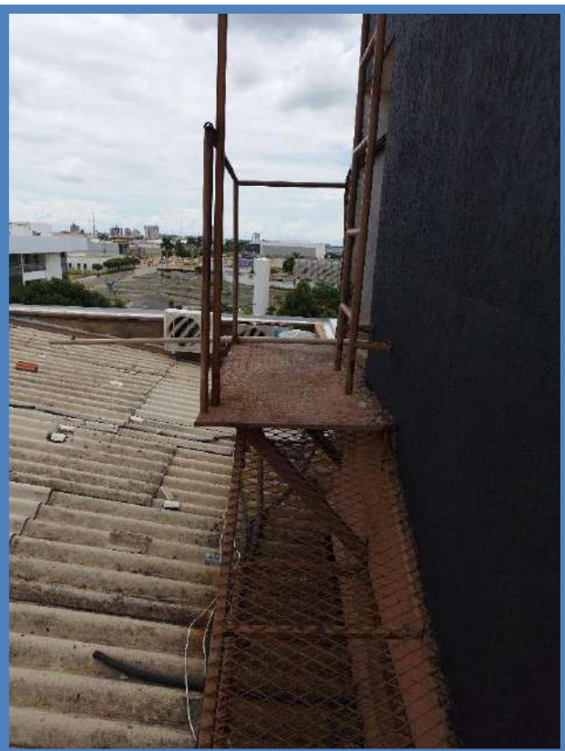
Figura 181: BLOCO B – COBERTURA
