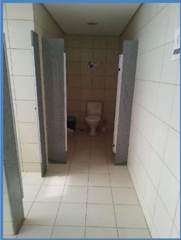
Figura 109: BLOCO A – 2º PAVIMENTO – SANITÁRIO MASC.
