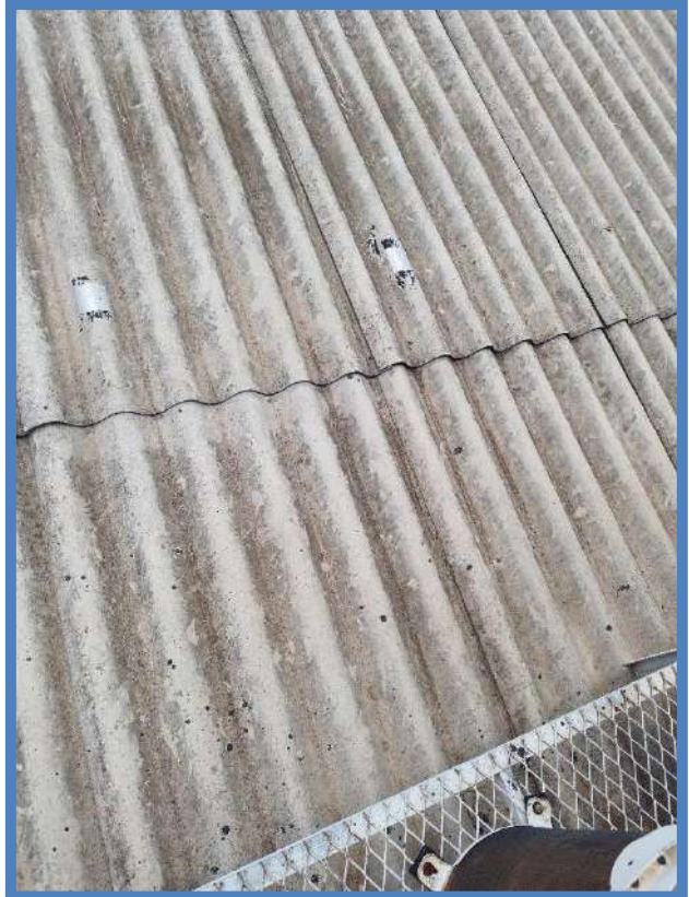
Figura 200: : BLOCO B – COBERTURA
