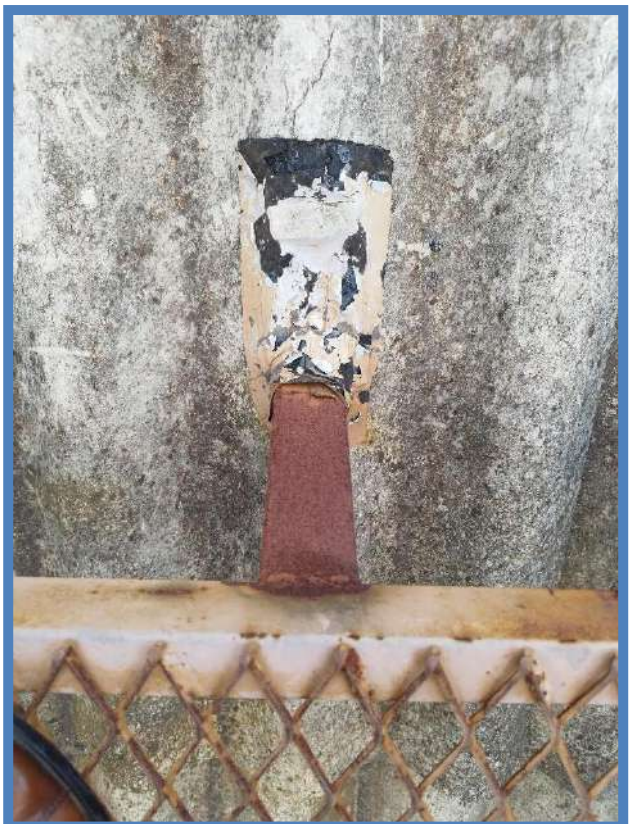
Figura 186: BLOCO B – COBERTURA
