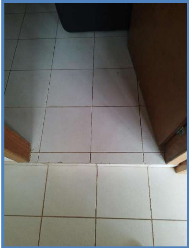
Figura 90: BLOCO A – 1º PAVIMENTO – SALA DOS VEREADORES
