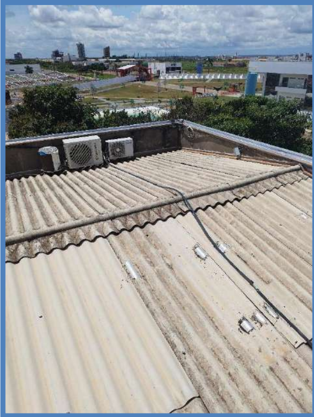
Figura 141: BLOCO A – 2º PAVIMENTO – COBERTURA
