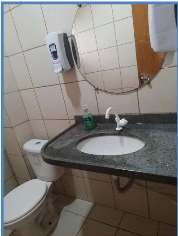
Figura 7: BLOCO A – TÉRREO – BANHEIRO
