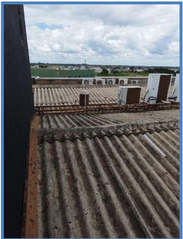
Figura 182: BLOCO B – COBERTURA
