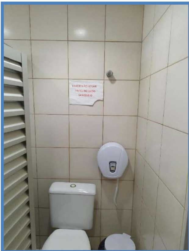
Figura 127: BLOCO A – 2º PAVIMENTO – SANITÁRIO FEM.
