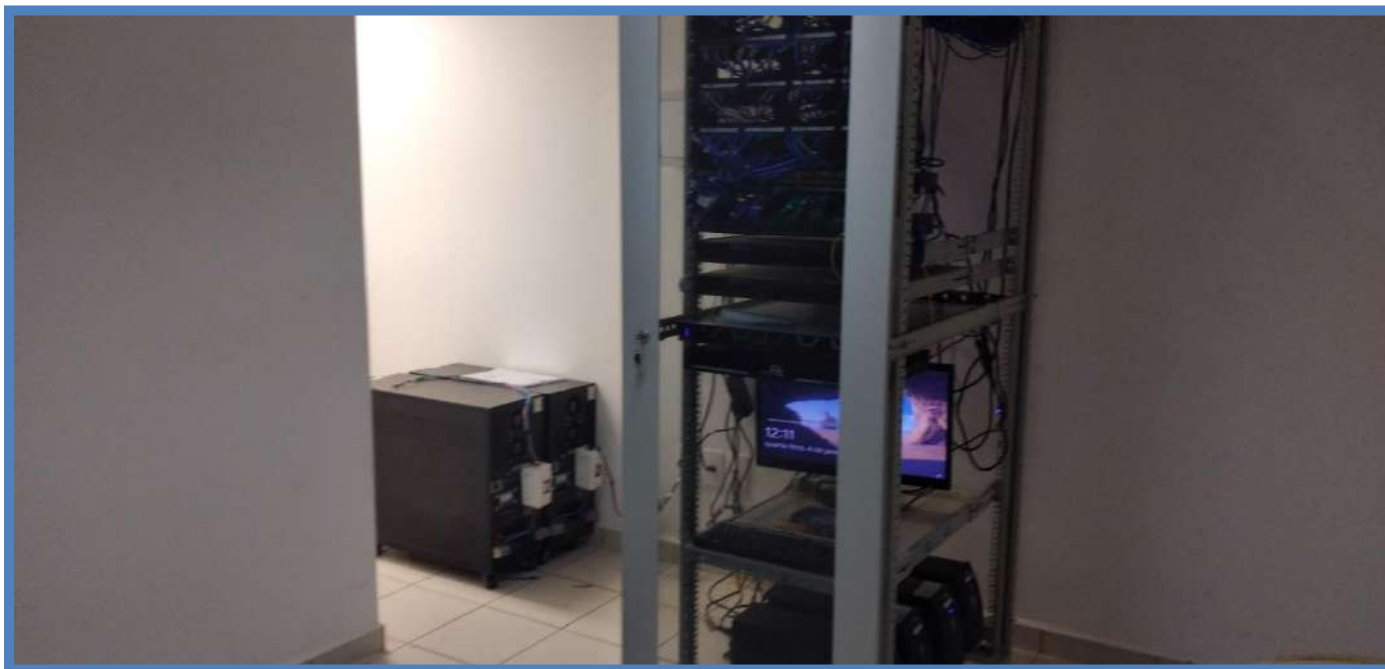
Figura 171: BLOCO A – 2º ANDAR – CPD
