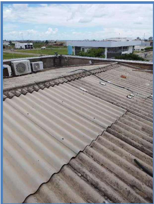
Figura 177: BLOCO B – COBERTURA
