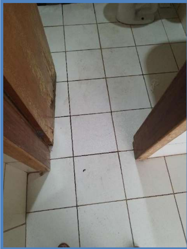
Figura 5: : BLOCO A – TÉRREO – ENTRADA BANHEIRO
