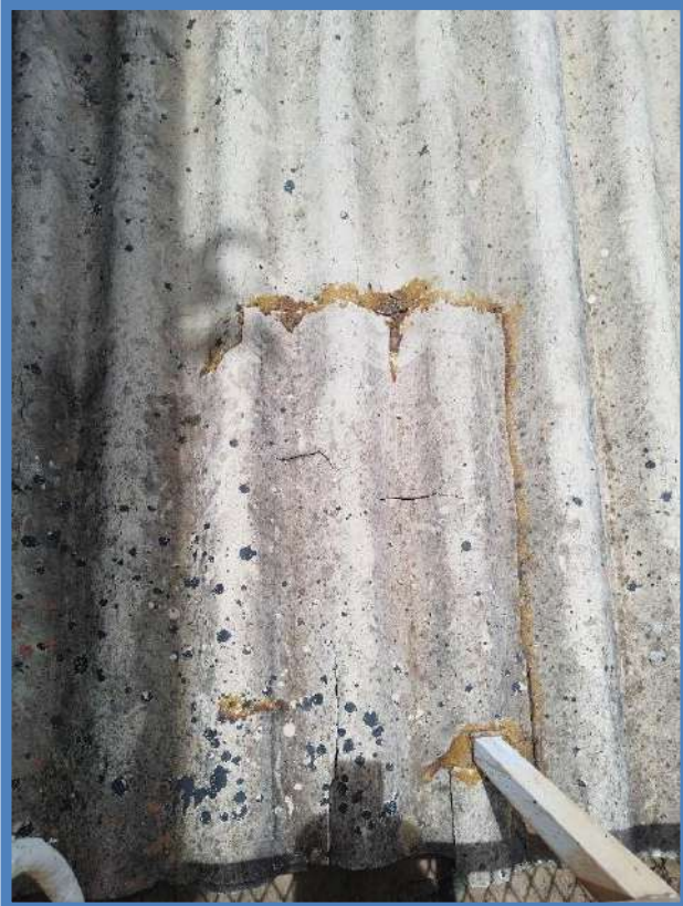
Figura 211: BLOCO B – COBERTURA
