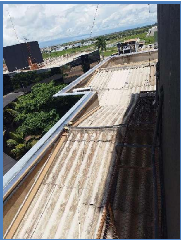
Figura 143: BLOCO A – 2º PAVIMENTO – COBERTURA
