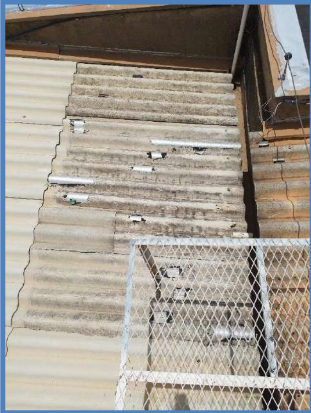
Figura 207: BLOCO B – COBERTURA
