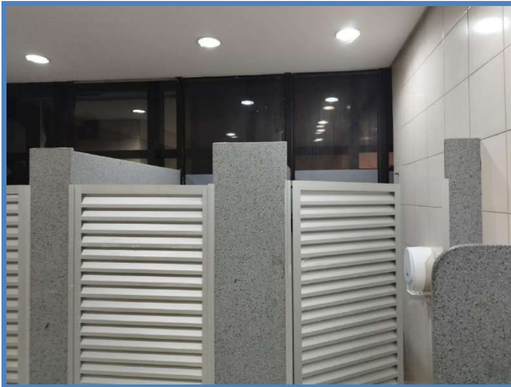
Figura 232: BLOCO B - 1º PAVIMENTO - BANHEIRO
