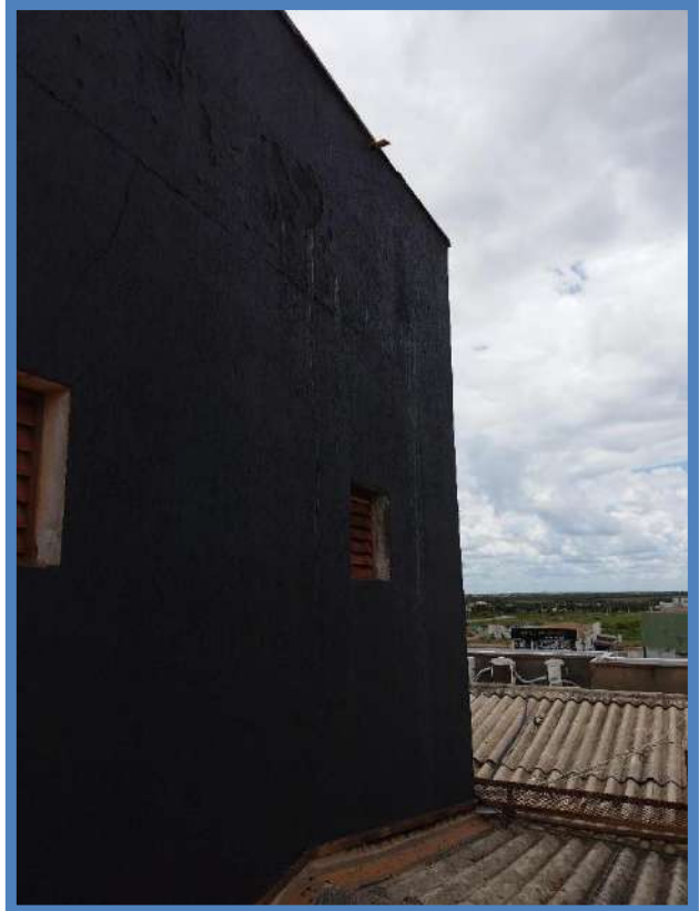
Figura 188: BLOCO B – COBERTURA
