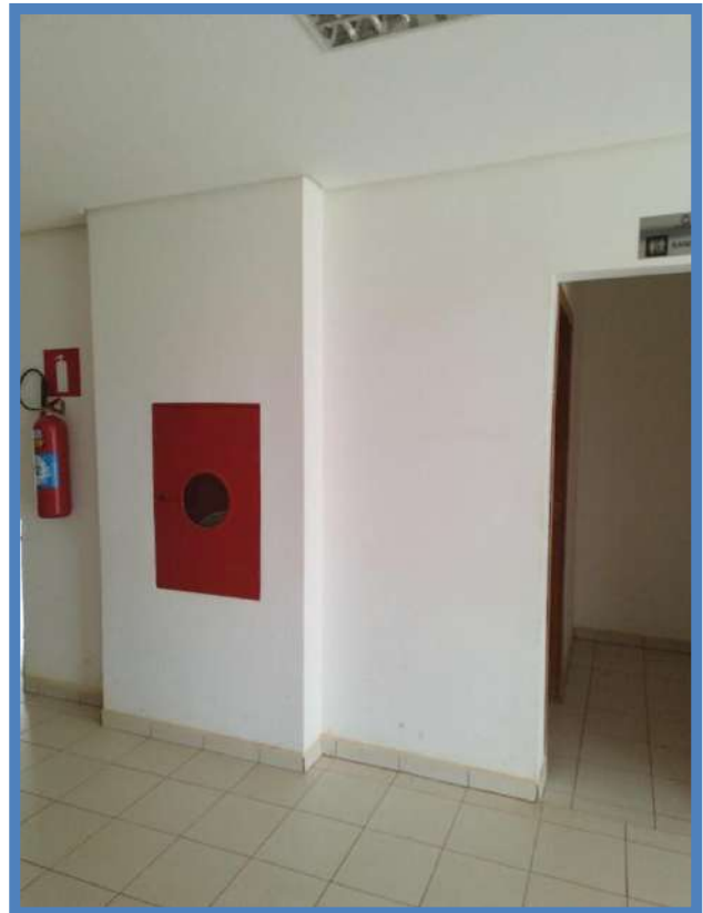
Figura 50: BLOCO A – 1º PAVIMENTO – HALL SANITÁRIOS
